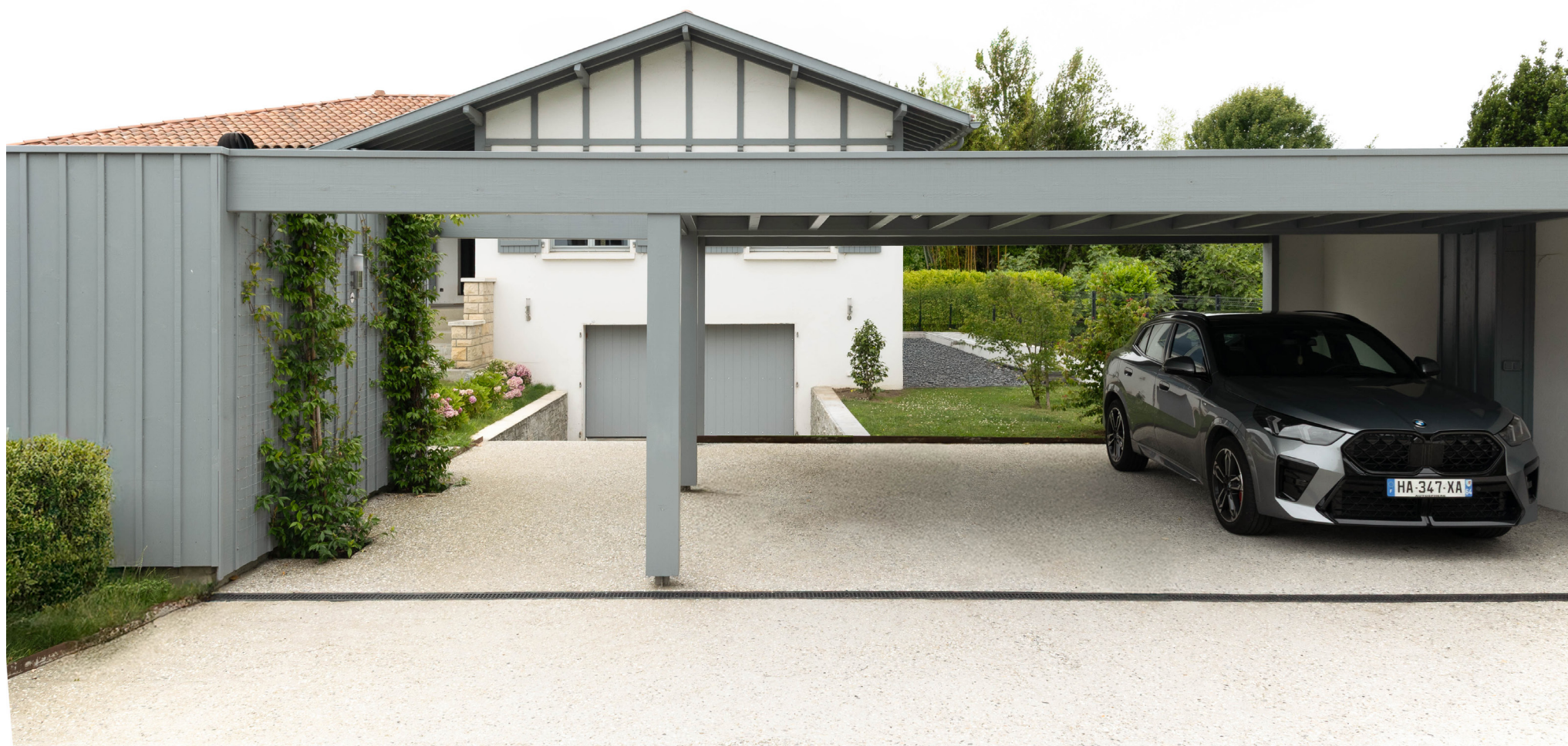
1. Vue d'ensemble de l'entrée et du carport 2. Détail de la végétation qui habille la structure en bois
